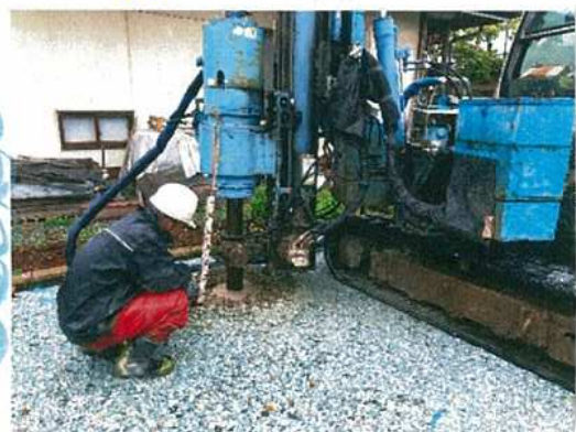
地盤改良工事
